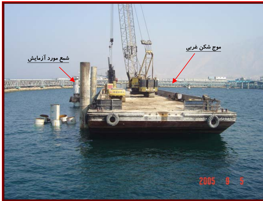
شکل ۲ نمایش موقعیت شمع مورد آزمایش و بارج پهلو گرفته جهت شمع کوبی
